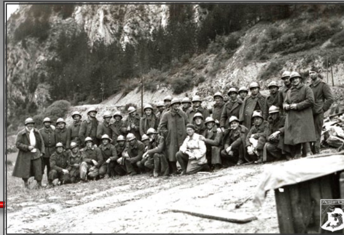
Ensemble de la batterie de 105 long sous Meyronnes.
