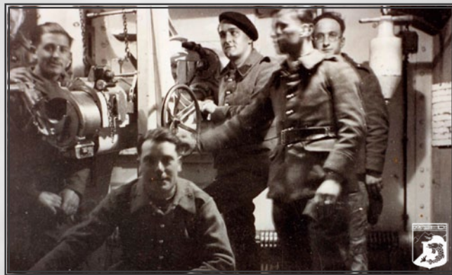
Photo-souvenir autour du matériel de 75 modèle 1931 du bloc 5 de Roche-la-Croix.
