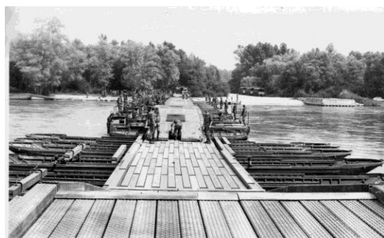
Figure 15. PAA et pont M4
